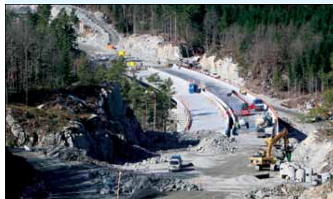
Verven bru like ved Lillesand: Oveland og Robusto på østsiden, Repstad Anlegg, Rørhuus Anlegg og Per Try på vestsiden.
